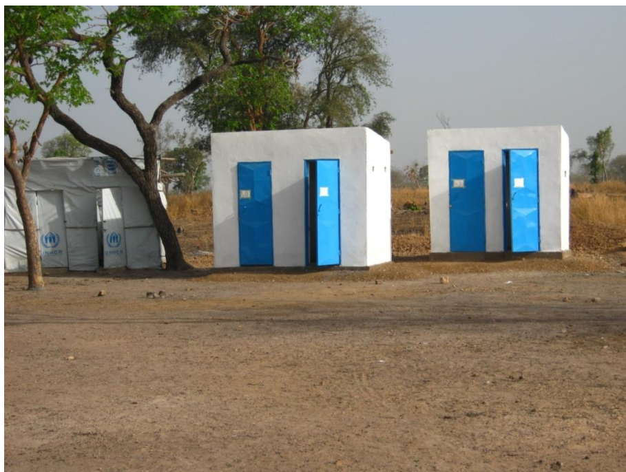
Construction d'un bloc de deux douches et de deux latrines pour la maternité de Moula
