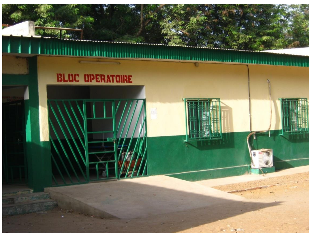
Bloc opératoire de Maro après réhabilitation en 2011
